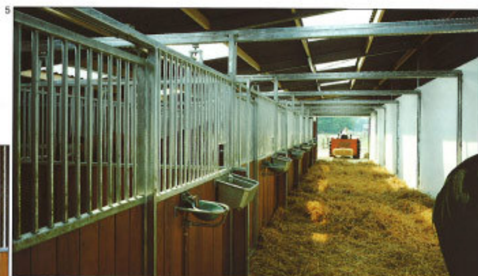
Stalschema met wegdraaibare tussenwanden
